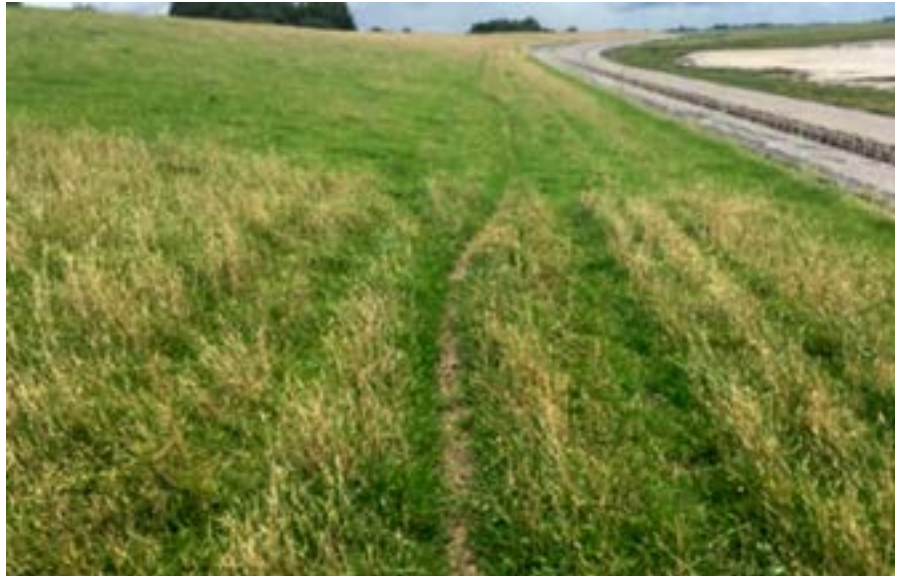
Foto 1: Deichböschung wasserseits mit Trampelfaden Richtung Süd-Osten.
