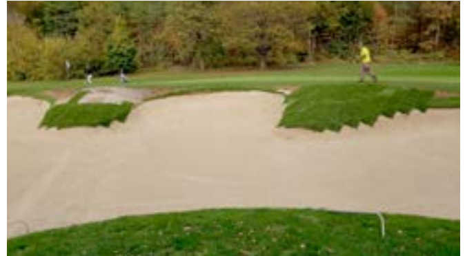
Abb. 3: Besodung der Bunkerzungen
